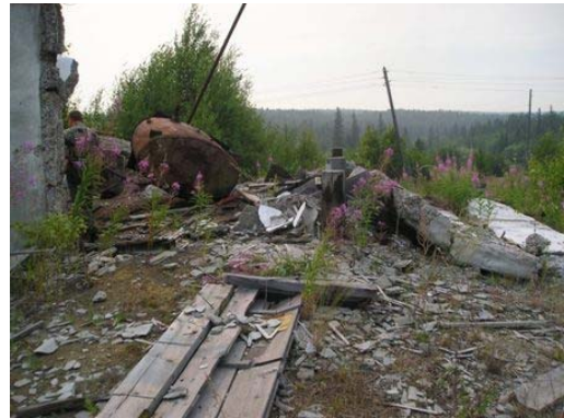
Разрушенный склад ГСМ в Проспихино
